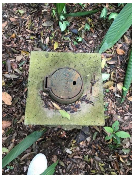
Figura 13: Interligação de esgoto da Estação Mata Atlântica.
